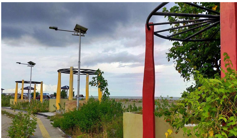
Bangunan Pergola pantai Pelangi Kota Sigli
